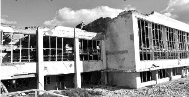
Будівля зруйнованого басейну
